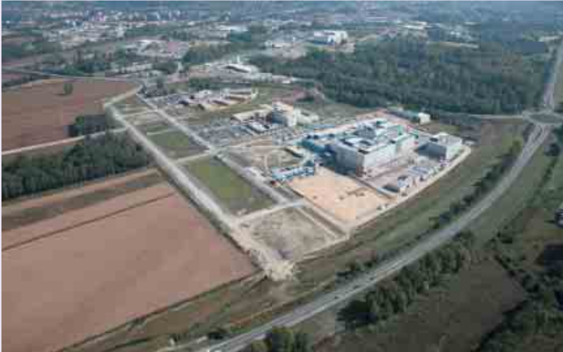
Médipôle vu de l'ouest
